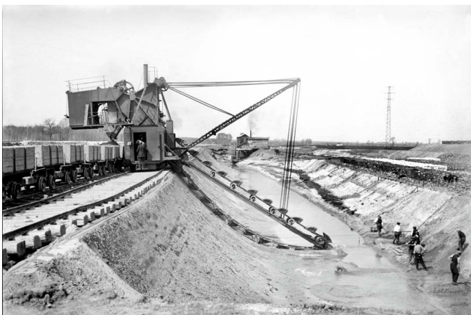
Hloubení nového labského koryta korečkovým bagrem u Brandýsa a Staré Boleslavi, 30. léta 20. století.
